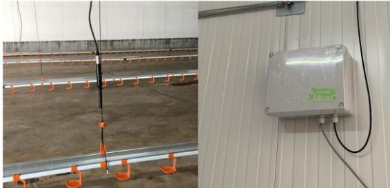
Mikrofon und Prozessor in einem leeren Stall an einer Stallwand installiert (bereitgestellt von Cealvet)
