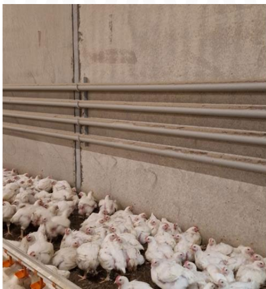
Els radiadors amb circulació d'aigua calenta garanteixen que els pollastres sempre tinguin la temperatura adequada durant la cria.
