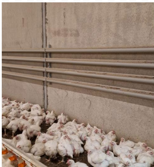
Los radiadores con circulación de agua caliente garantizan que los pollos siempre tengan la temperatura adecuada durante la cría.
